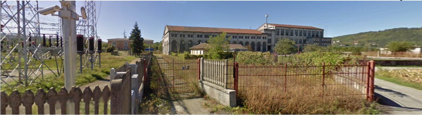
VEDUTE di Google Street View relative alla sottostazione elettrica e all'area D1-1b dalla strada di Località Val d'Arquata
