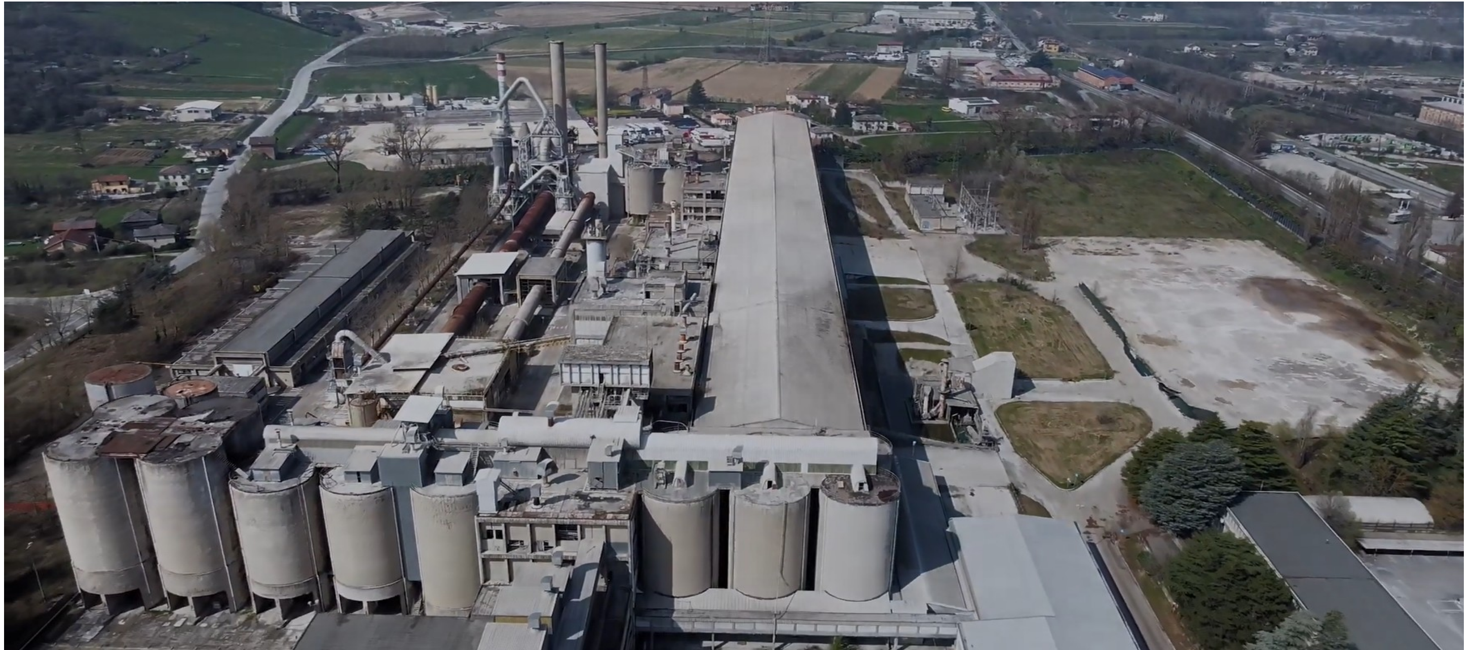
Immagini estratte dalla “Produzione video per Officine Mak – ex Cementir di Arquata Scrivia” effettuato in epoca contemporanea, immediatamente prima della fase di demolizione degli edifici e degli impianti produttivi
