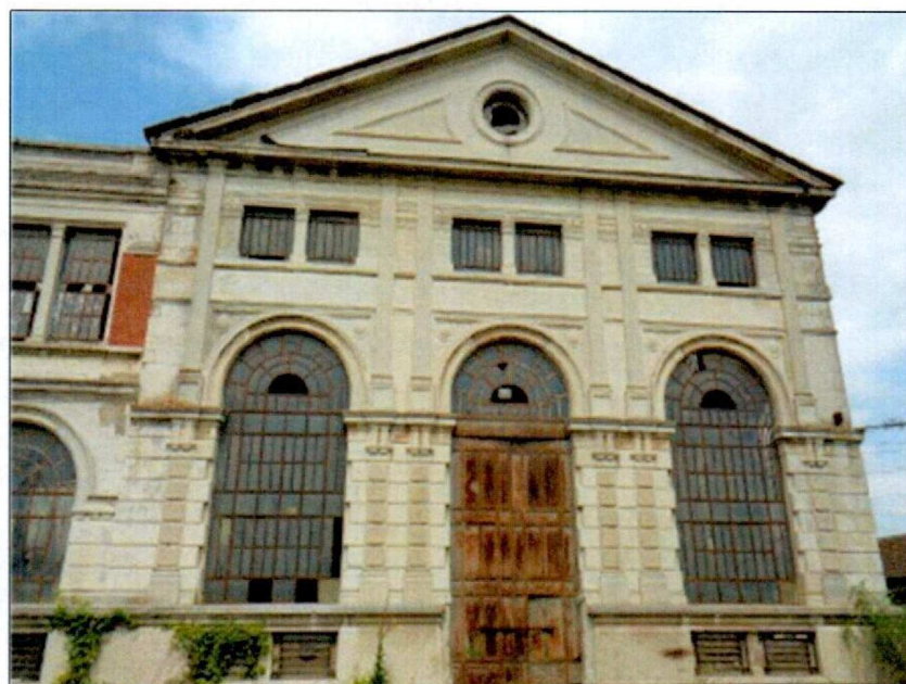
Foto 1: Vista del prospetto esterno
