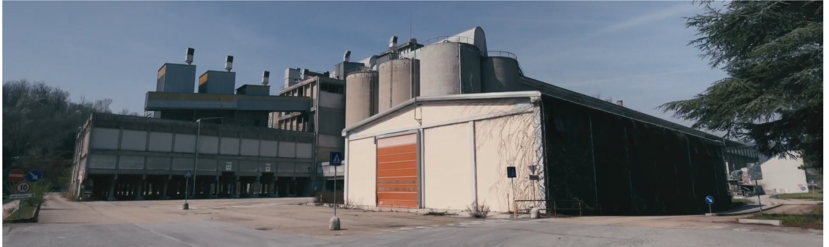
Immagini estratte dalla “Produzione video per Officine Mak – ex Cementir di Arquata Scrivia” effettuato in epoca contemporanea, immediatamente prima della fase di demolizione degli edifici e degli impianti produttivi
