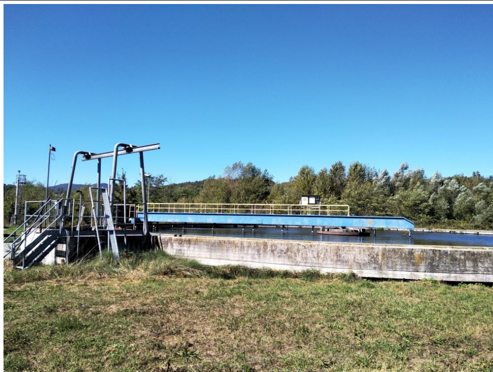
Immagine fotografica 4/4 [sedimentazione secondaria e pozzetto ricircolo fanghi]
