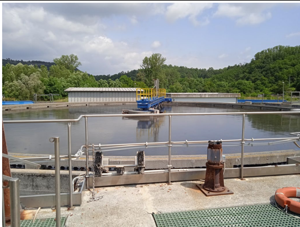
Immagine fotografica 2/4 [nuova predenitrificazione / ex-sedimentazione primaria]
